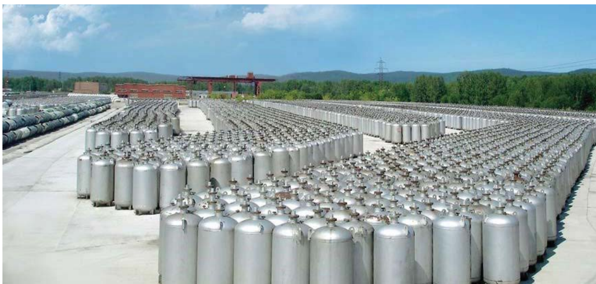
Площадка хранения ОГФУ
