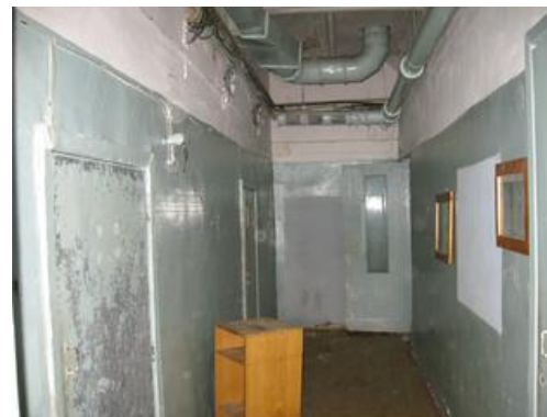
Помещения в производственном здании склада ГСМ
