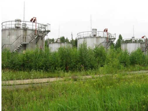
Открытая площадка с резервуарами для хранения ГСМ
