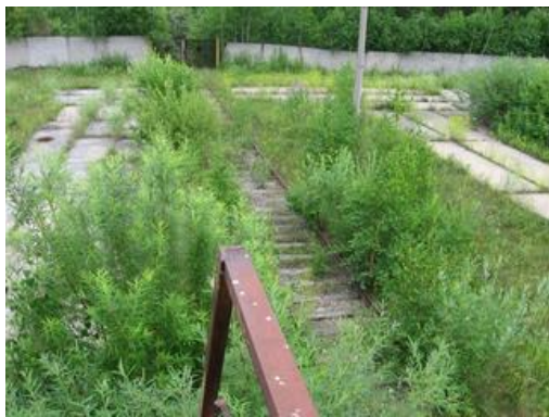
Подъездной ж/д путь склада ГСМ
