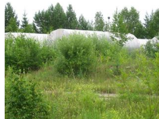
Открытая площадка с резервуарами для хранения ГСМ
