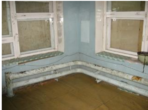
Помещения в производственном здании склада ГСМ
