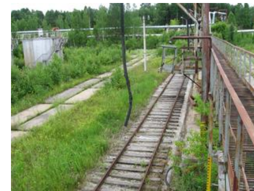
Подъездной ж/д путь склада ГСМ
