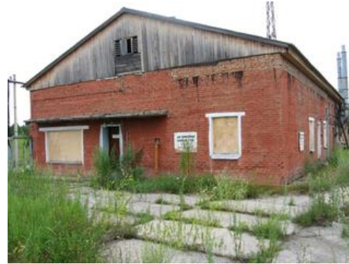
Производственное здание склада ГСМ
