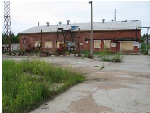
Производственное здание склада ГСМ
